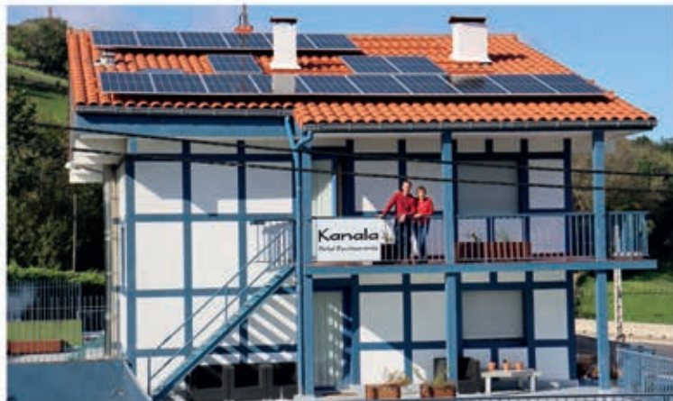
Plaka-fotovoltaikoak Itziarko Kanala jatetxean. DKT
