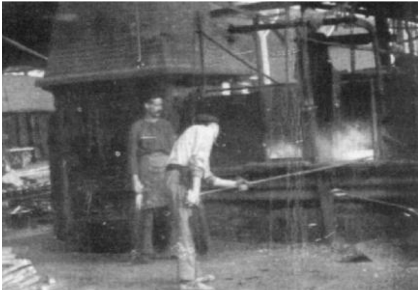
Ezkerreko argazkian San Pedroko bi langile labean materiala berotzen, ondoren laminazio prozesuari ekiteko. Eskuman, San Pedroko langileak 1945. urtean.
