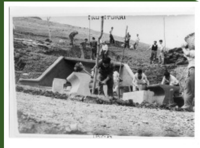
1947an inauguratu zuten Hiru-lturri iturria. San Pedroko eta San Migeleko baseritarrek lagunduta, auzolanean jaso zuten.
