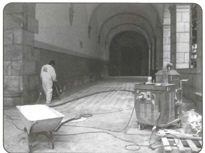
Apurtutako losak aldatu ostean fresatzeko makinarekin aritu dira lanean arkupeetan.
