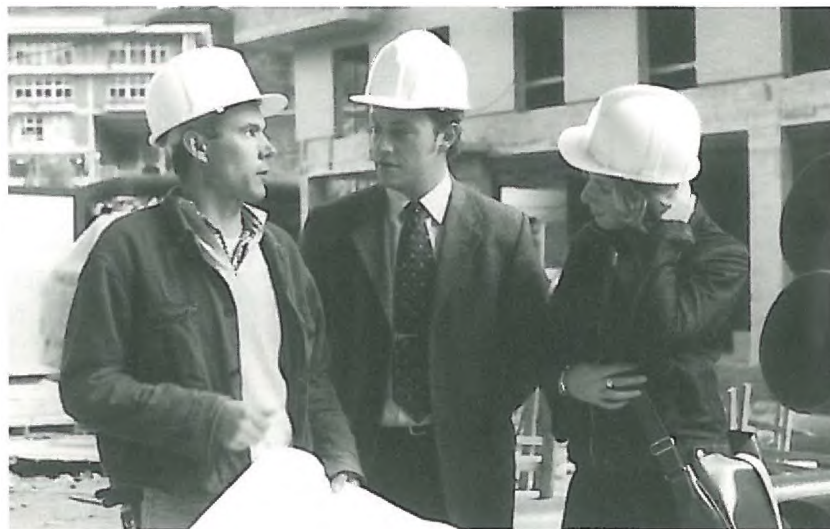
Silbia eta Koldo etxe berria ezaritzeko zuzendatzaileak eta inkesta handiarekin jarraitzen dituzte obrak.
