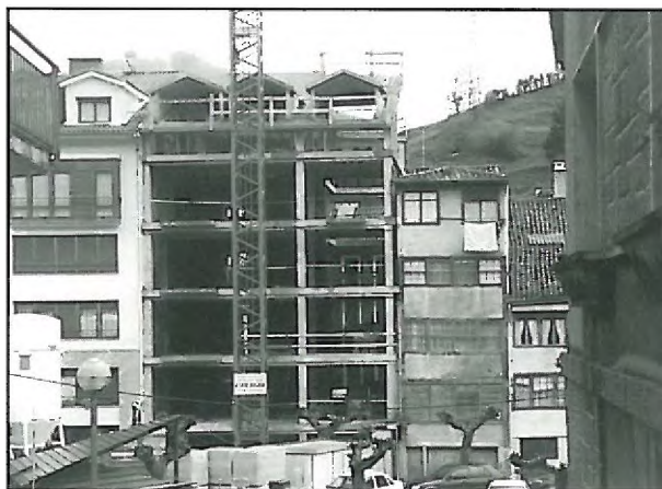
Plan honen bidez eraildnetan igogailuen instalazioak, antenak, telefonia eta gas naturala jarriko dira, baita fatxadak eta teilatuak konpondu ere,
