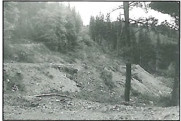
Terreno horietako lanak bukatu ondoren, baliteke Udalak errepedea ere konpontzea.
