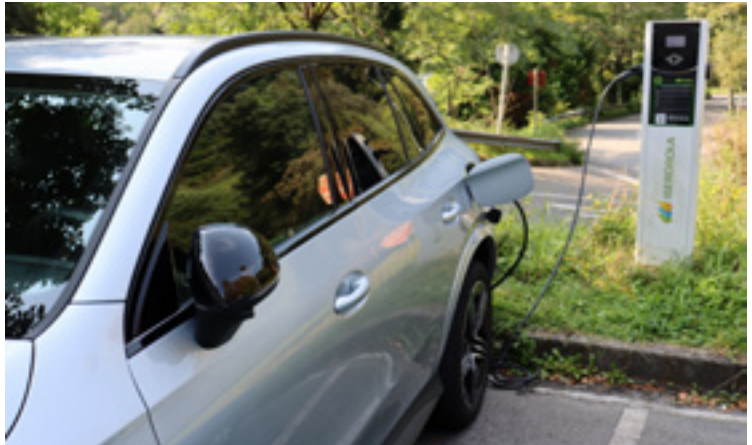
Auto elektrikoentzako kargalekua Azitaingo industrialdean (Eibar). DKT
