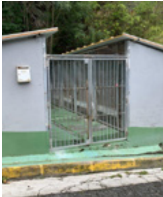
Harrera zentroaren instalazioak.
