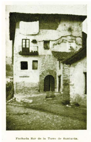
Fachada Sur de la Torre de Santucua.
