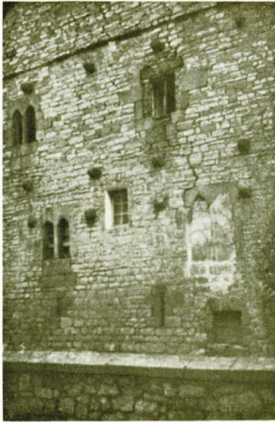
Detalle de la fachada Oeste de la Torre de Loviano.
