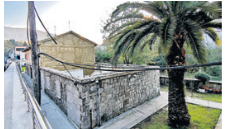
Lehen solairurik eta estalkirik gabe saltzen dira eraikinak. ASIER ORBEA
