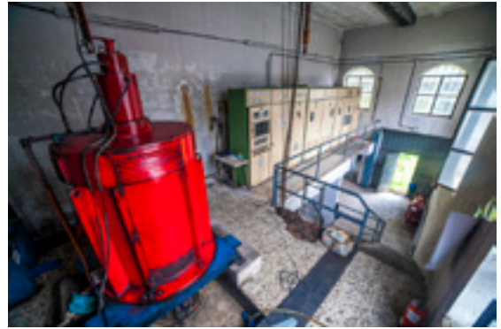
Kaplan motako turbina, ardatz bertikalekoa.
